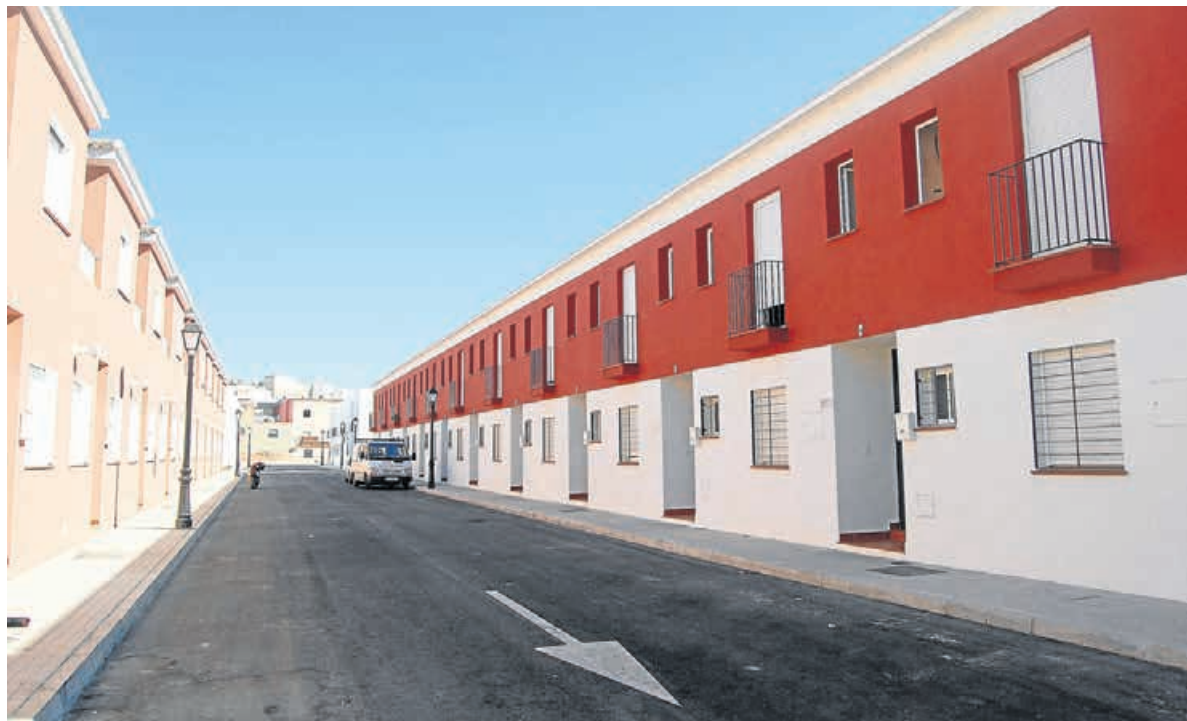
Las viviendas sociales de La Vega que el Ayuntamiento pretende adquirir en breve. / El Correo
